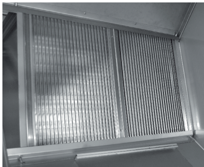
Пластинчатый рекуператор (рис. 12)
